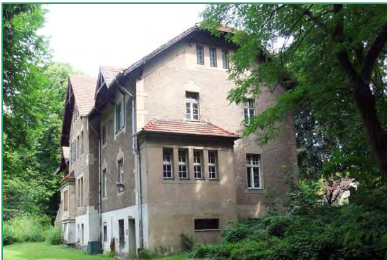
Schwielowseestr. 72: Das denkmalgeschützte Gebäude bietet Fledermäusen Sommerverstecke.
