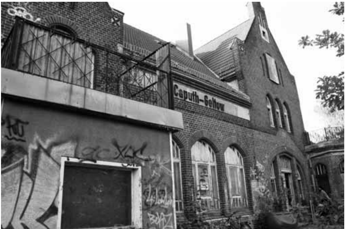
Der Anbau im Vordergrund am Bahnhofsgebäude Caputh-Geltow sowie die Graffiti-schmierereien werden verschwinden.
