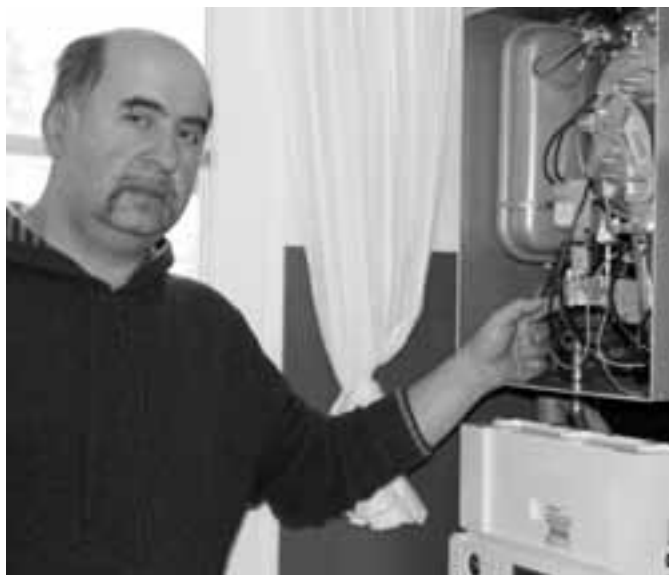
Thomas Weigt an einer Gasbrennwerttherme
