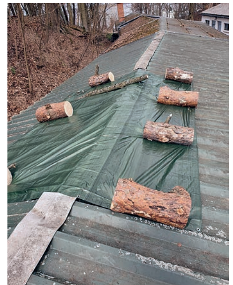
Notreparatur am Dach der Schießhalle Foto: Schützengilde
