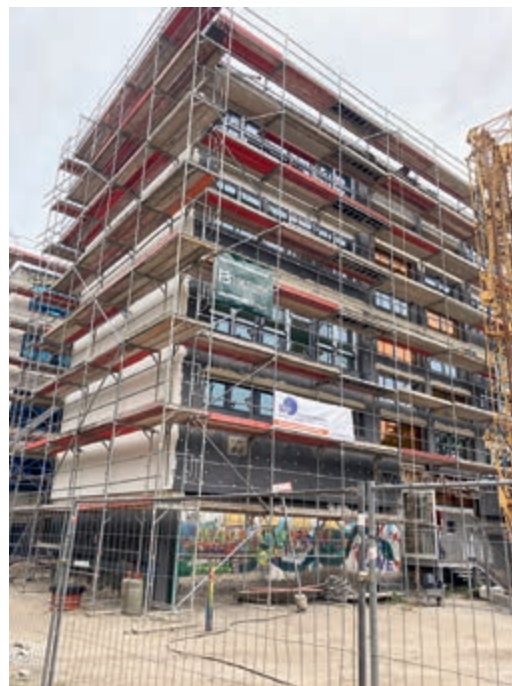
Die Sanierung des Bestandsgebäudes liegt im Plan Foto: Ingrid Schlegel
