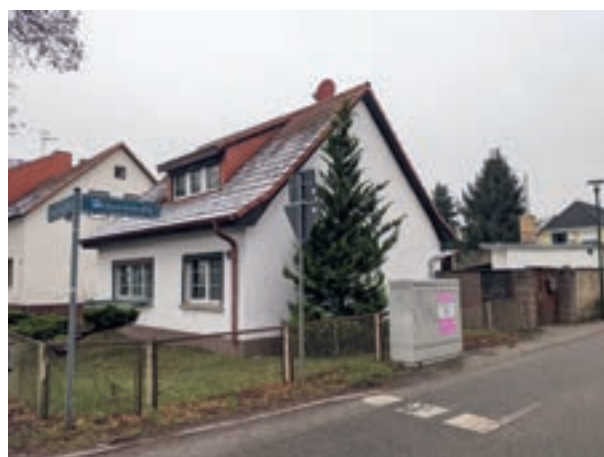
Wildparkstraße: Nach dem Konzept ist hier eine Verringerung des Kfz-Verkehrs geplant Fotos: Regina Petschke
