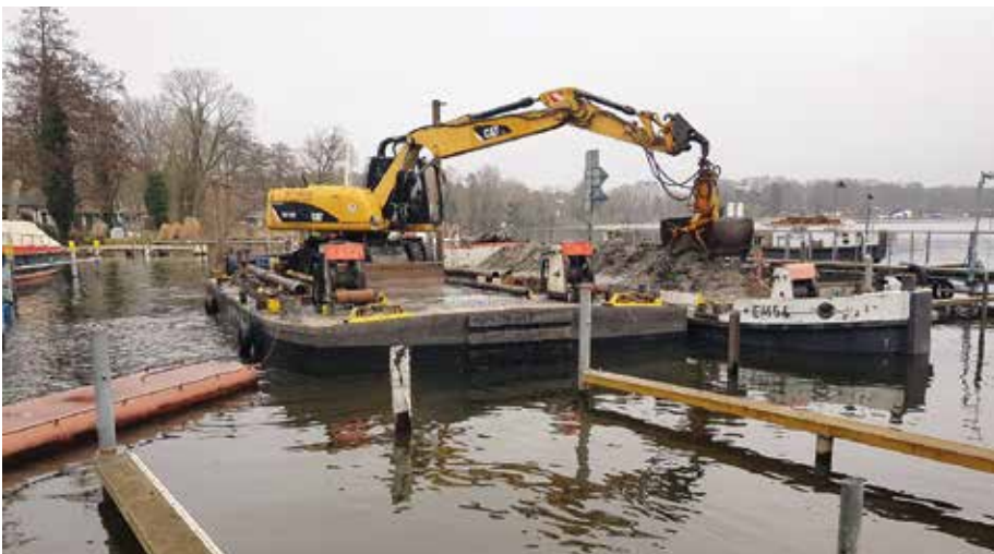
Schlamm und Sand verringern die Wassertiefe jährlich um einen Zentimeter. Der Bagger sorgt für ausreichend Wasser unterm Kiel. Foto: Heiko Hoffmann
