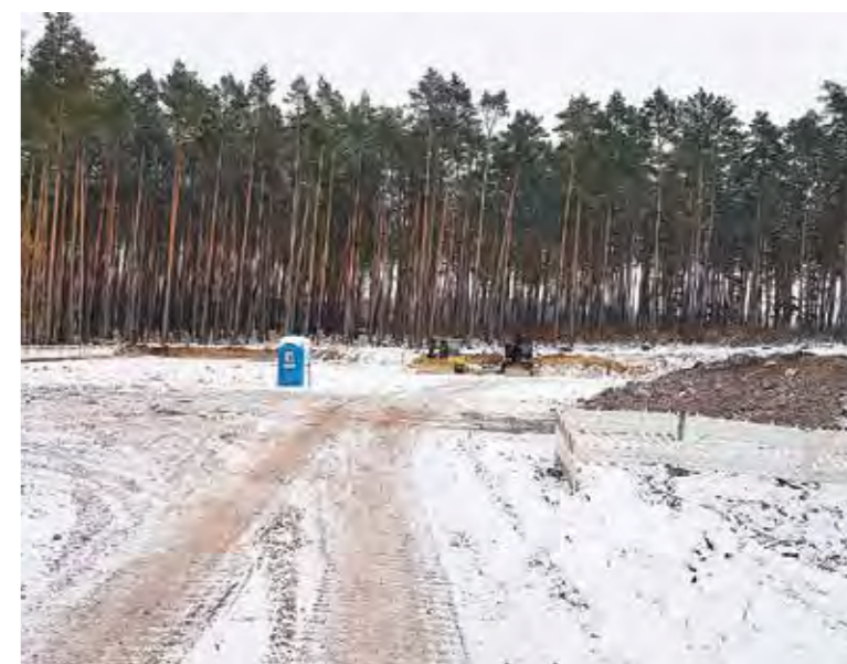
Baustelle Windrad „Am Dachsberg“ im Winterschlaf Foto: Marina Katzer
